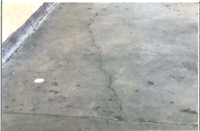
Foto 4: Reparacion y sustitucion de azulejos
